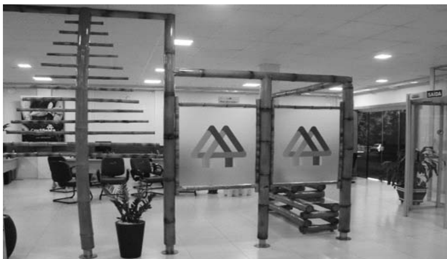
Figura 04: Estrutura de bambu na sede da Crediseara
